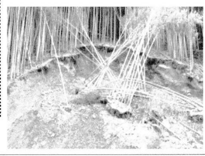
和木町の土砂崩れ現場
