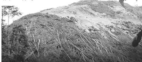
写真は工事に伴う伐採の様子
